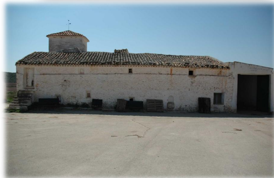
Foto nº 6. Era y acceso a la cámara y pajar. Puerta principal de la casa situada a la derecha del edificio, aunque seguramente, la entrada estaría en concordancia con el camino principal, es decir, a la derecha de donde se ve actualmente.
