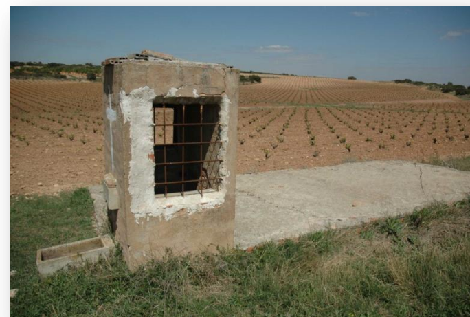
Foto nº 2 y 3 (Aljibe vista exterior e interior).
