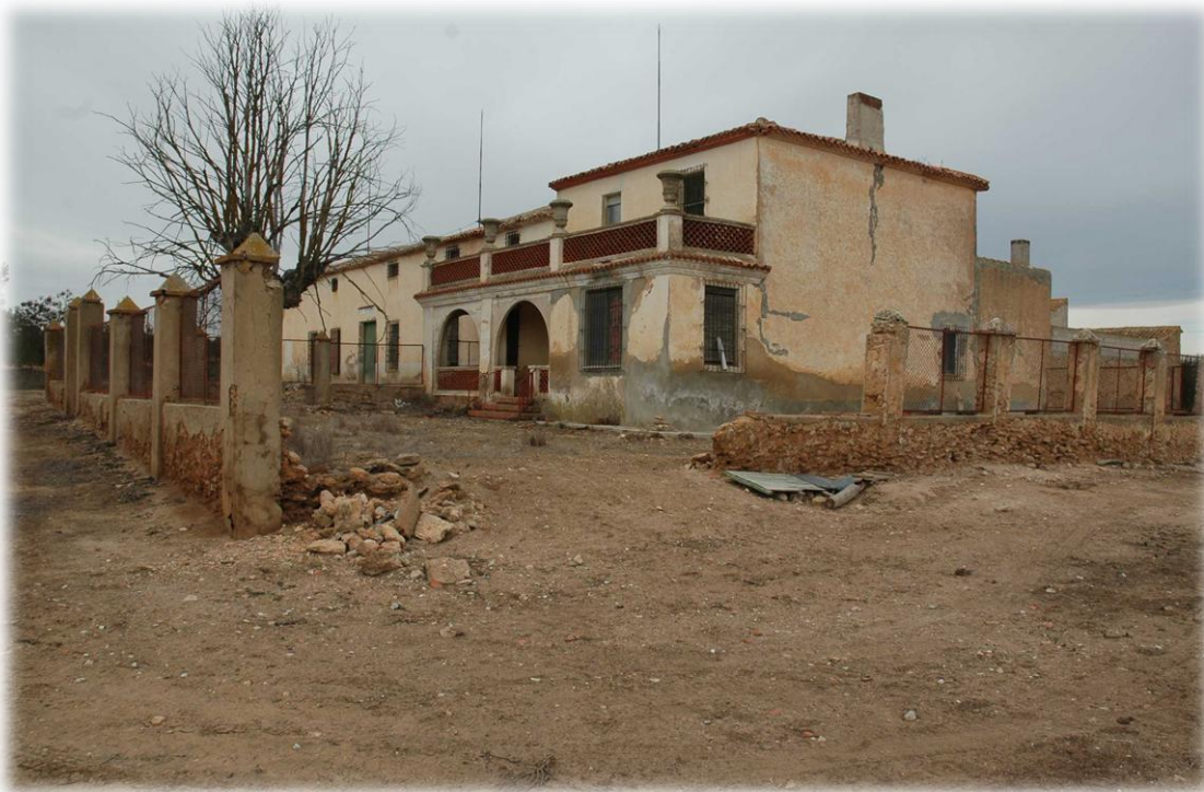
Foto nº 1. Detalle de la obra más reciente (1970).
