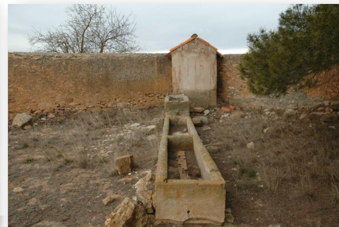
Foto nº 5. Detalle del pozo.
