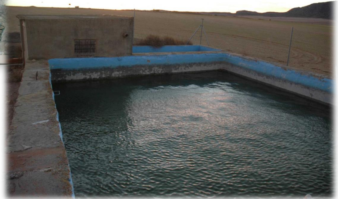
Foto n° 4. Balsa y pozo.
