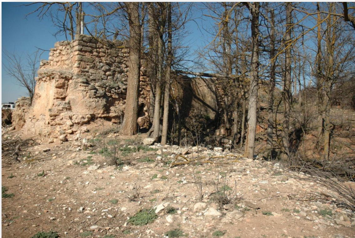
Foto nº 1. Detalle del acceso principal.
