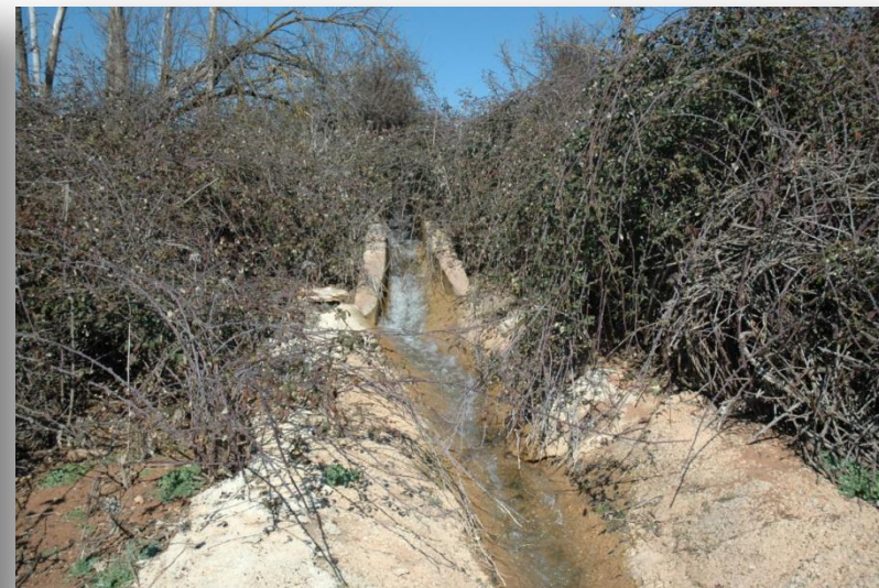
Foto nº 2 y 3. Canal de salida del molino.
