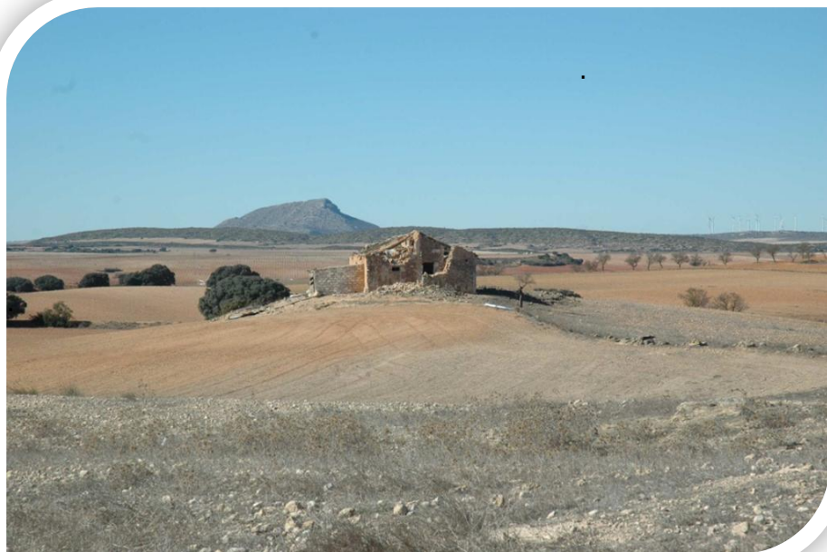
Foto nº 11, 12 y 13. Vistas de la Casita de “La Francesa”.
