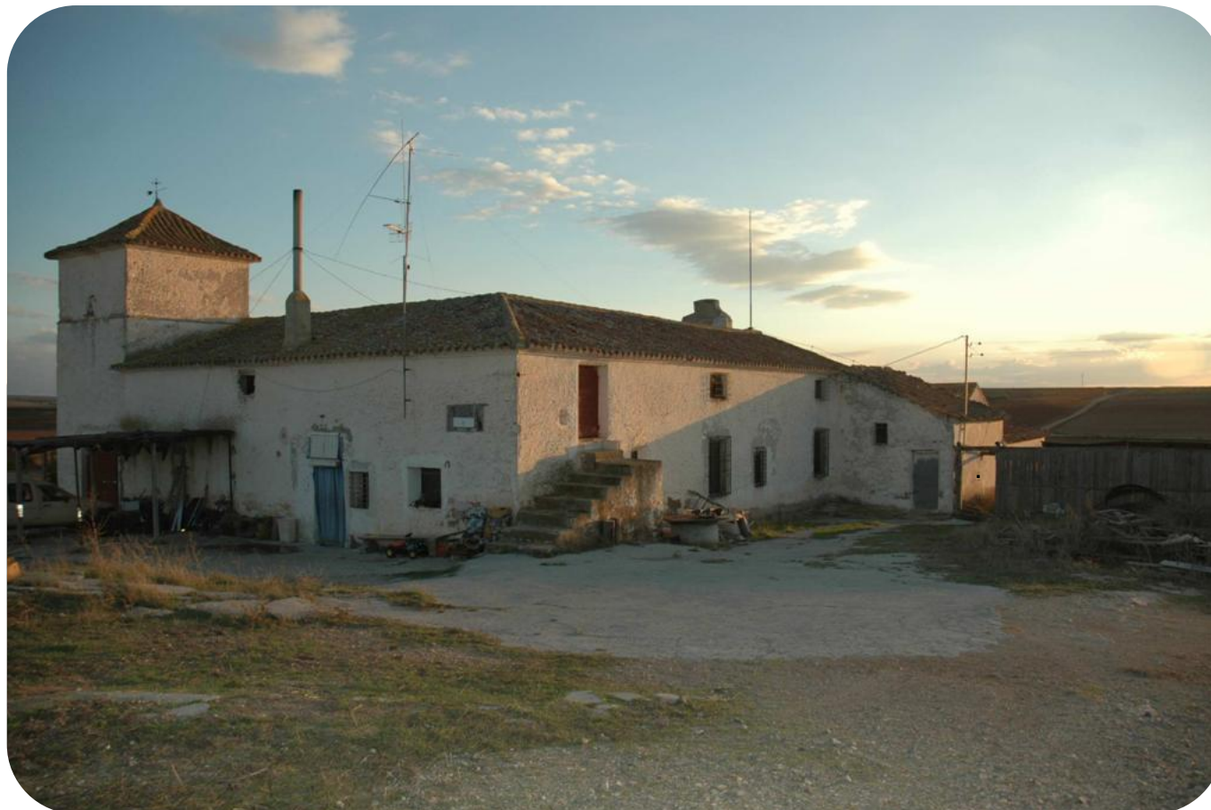
Foto nº 1. Vista general de la casa.
