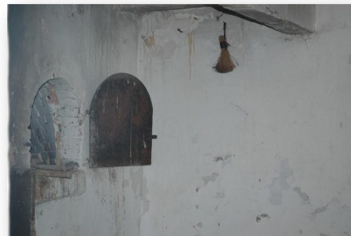
Foto nº 4. Detalle del horno.
