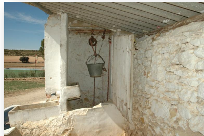
Foto nº 3. Detalle del pozo.
