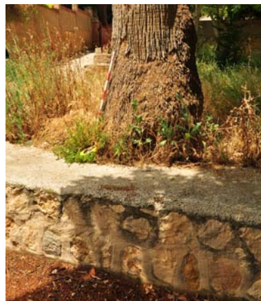
Muro perimetral a modo de alcorque.
